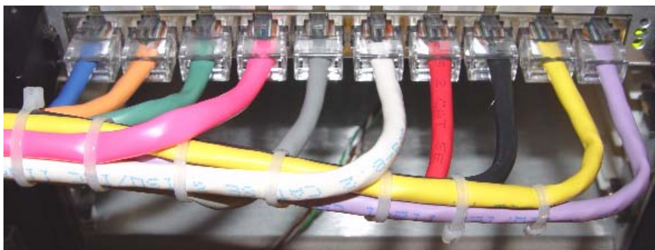
図 1-11 まとめられた FE10 の ケーブル
