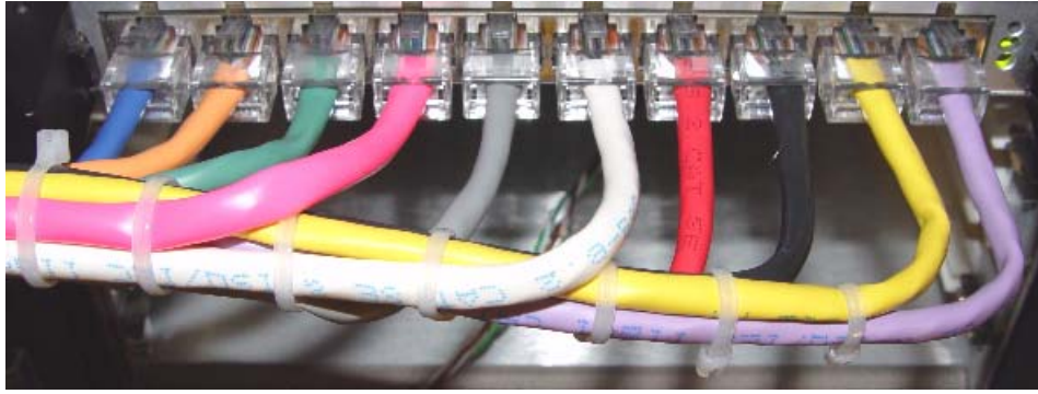
図 1-19 まとめられた FE10 の ケーブル
