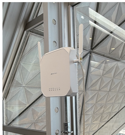
同イベントの情報発信を支えたアライドテレシスの「AT-TQ7403-R」。Wi-Fi 6E (IEEE 802.11ax)に対応する無線機能とルーター機能を統合したモデルだ。
